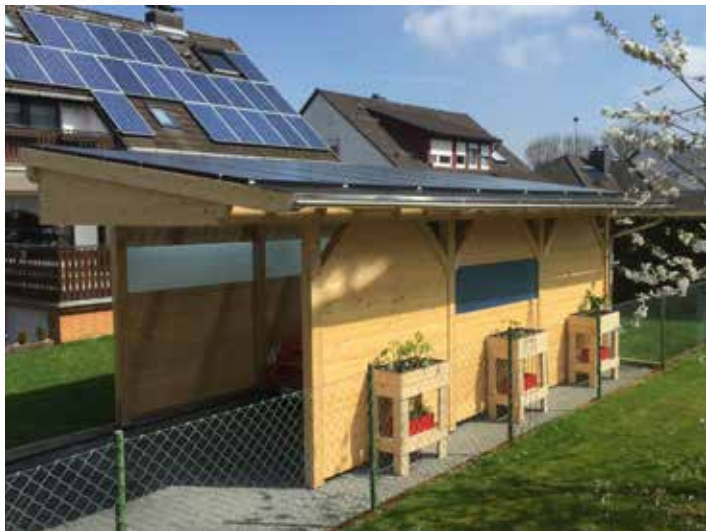
Wohnhaus mit PV-Anlage. Foto: esg-solar.de
