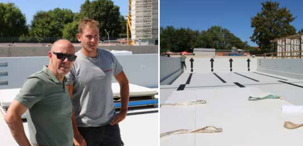
Jörg Schnitzerling (ASC Göttingen, links) mit David Becker (Fa. Steuler) bei der Kontrolle des Schwimmbeckeneinbaus.
